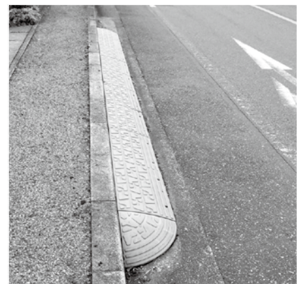
違法に設置された段差解消ステップ
