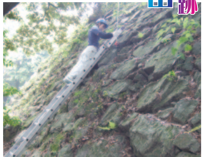
本丸高石垣測量風景
