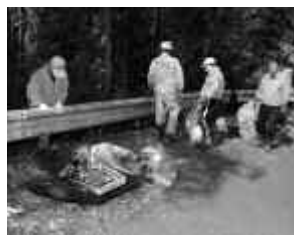
栃本町側の作業の様子
